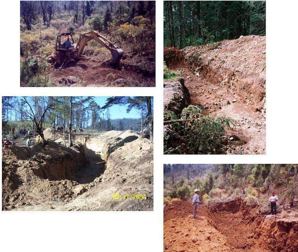
Figura 7. Ejemplos de zanjas construidas en la región para cortar el acceso a los talamontes (fotos WWF)
