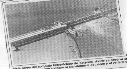
Vista aérea del complejo hidroeléctrico de Yacyretá, donde se observa la Casa de Máquinas que contiene la transferencia de peces y el vertedero principal.
