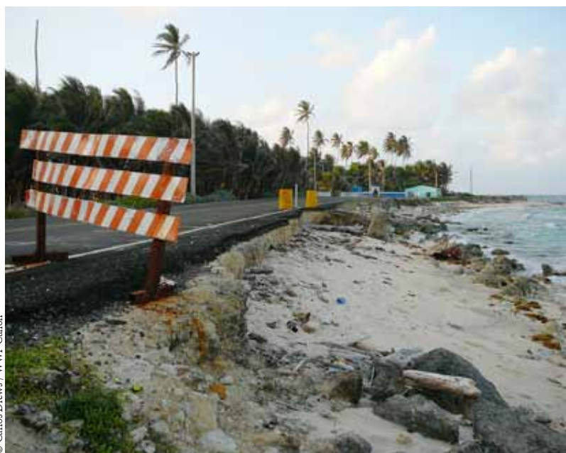
▲ Erosión en vía costera en la Isla de San Andrés, Colombia. Causado posiblemente por el incremento del nivel del mar, gracias al cambio climático.
