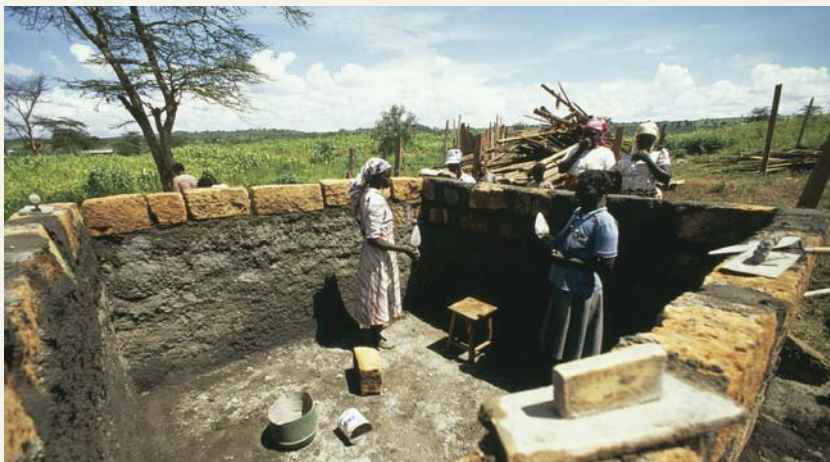
Des femmes préparent du mortier pour une citerne proche du lac Nakuru au Kenya
